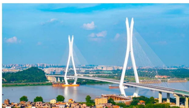
图 5 佛山市富龙西江特大桥主桥
